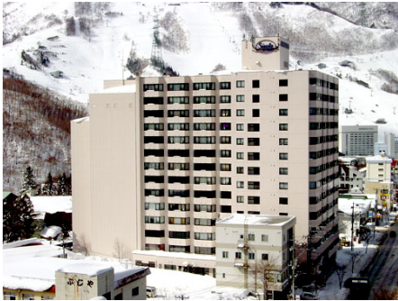
外観（国道17号線沿い）
