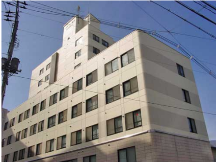
外観 (温泉街沿い)
