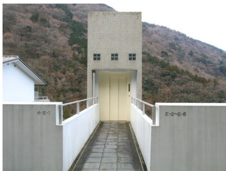
エレベーター
