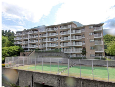
マンション外観 (D棟)
