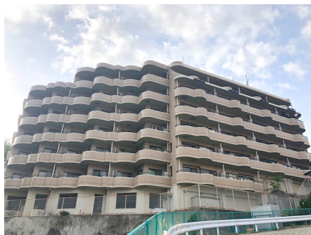
東側からの外観
