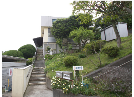
管理室・温泉棟入口
