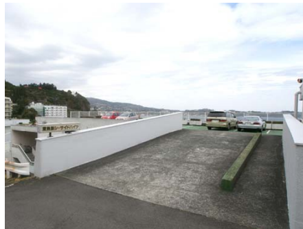
入口スロープ
