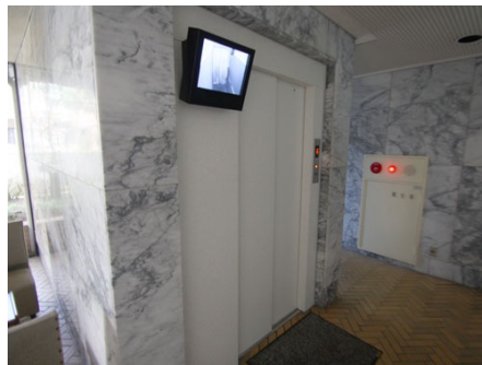
エレベーター
