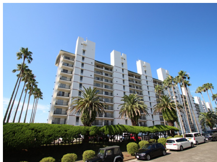
A棟の外観
