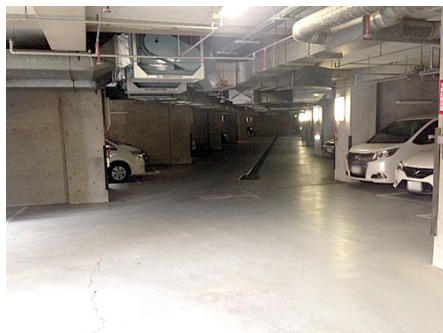
地下平置駐車場
