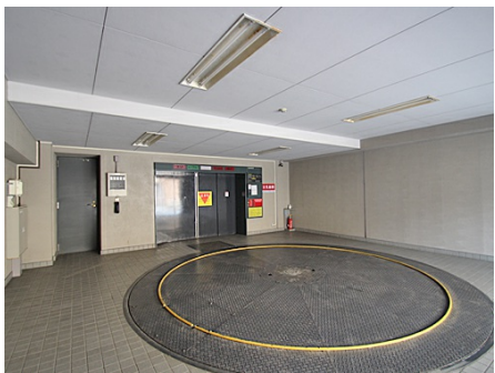
機械式駐車場
