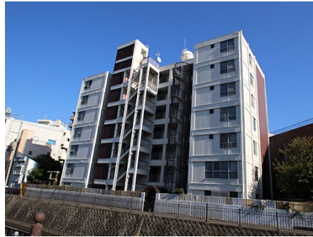
逗子葉山駅側からの外観
