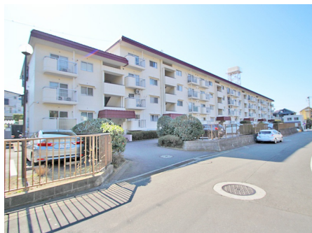
駐車場側からみた外観
