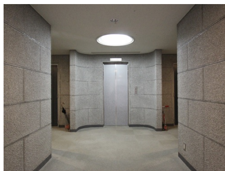
エレベーター
