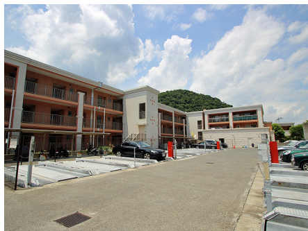
機械式駐車場
