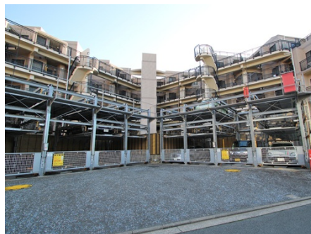
機械式駐車場
