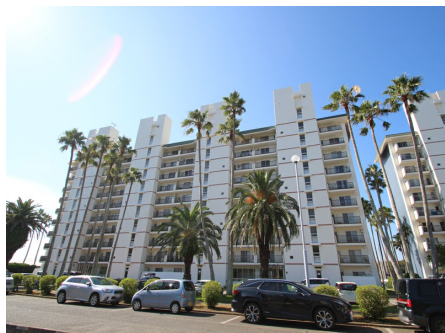
A棟の外観
