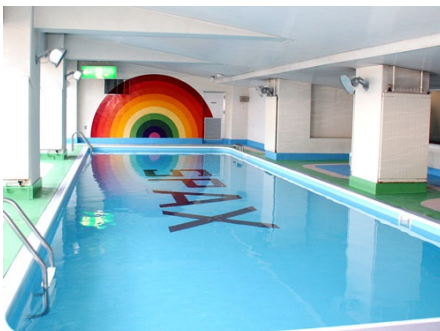
室内温水プール
