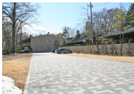
駐車場の様子
