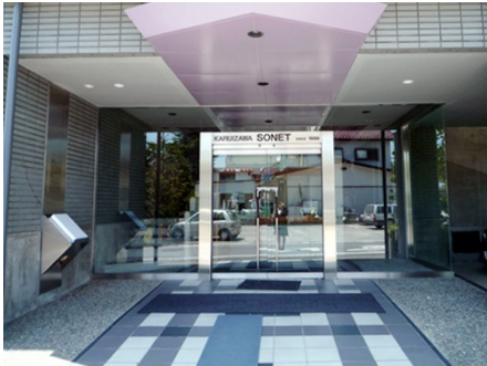
エントランス外観
