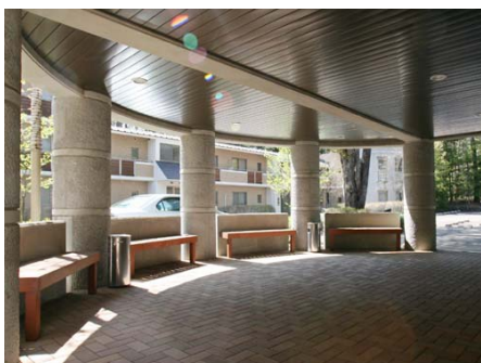
休憩スペース
