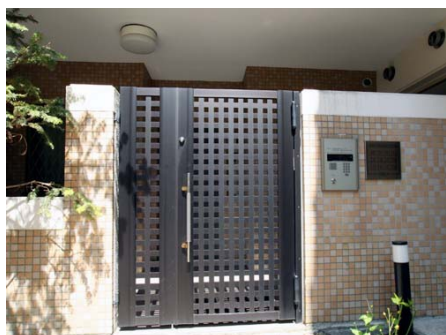
棟別のオートロック
