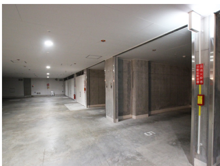
地下分譲駐車場
