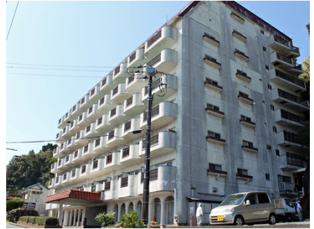
マンション全景
