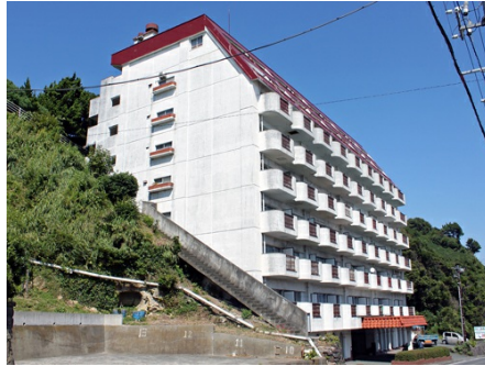
マンション全景
