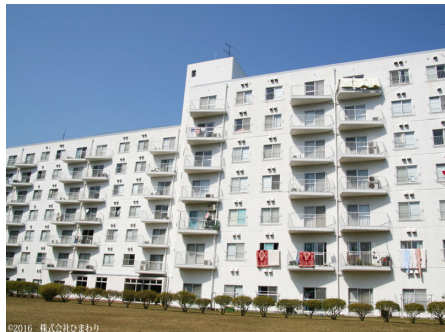
外観エントランス周辺
