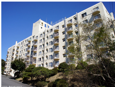
南側からの全景
