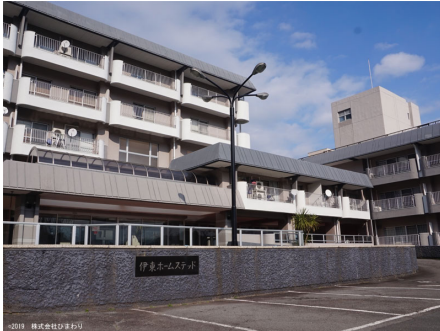
車寄せのあるマンション外観
