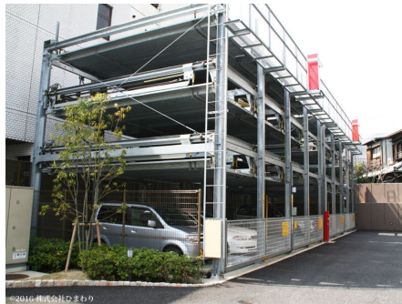
機械式駐車場
