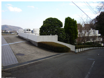
屋上駐車場入口
