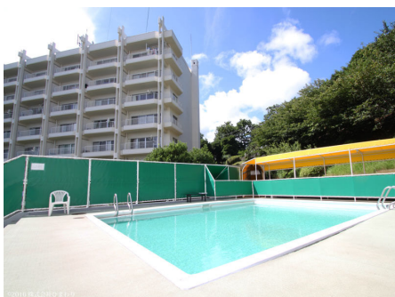
屋外プールより1号棟
