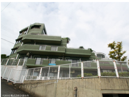
全面道路より見あげる
