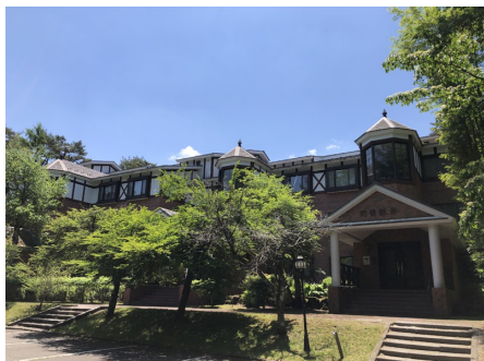
外観（2番館・エントランス側）
