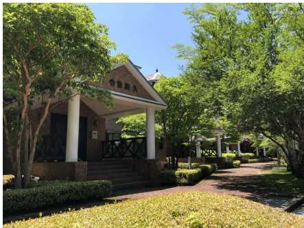
外観（1番館・エントランス側）
