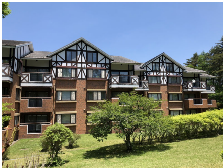
外観（1番館・南西側より）
