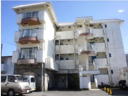
マンション外観
