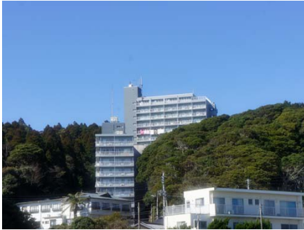
マンション外観（奥が2号館）
