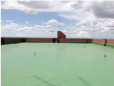
マンション屋上
