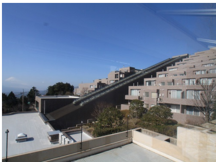
中央は斜行エレベーター
