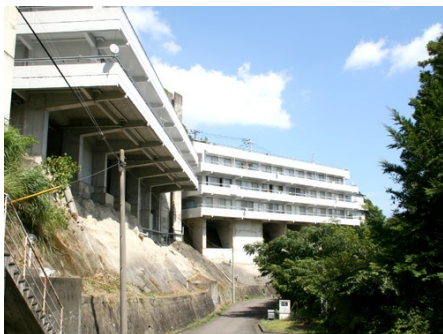
駐車場からの外観
