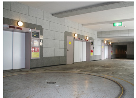
屋内機械式駐車場
