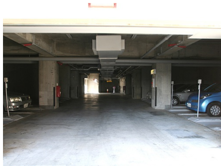
機械式駐車場
