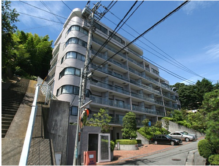
マンション外観 全景
