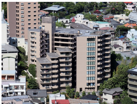
マンション外観 全景
