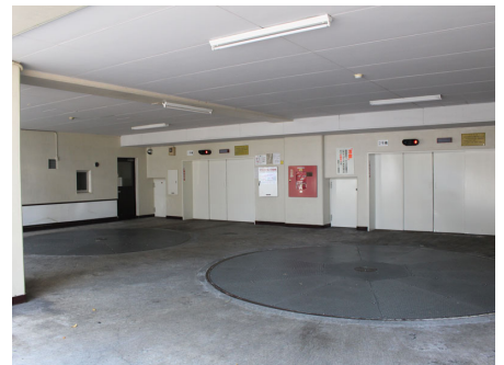
機械式駐車場
