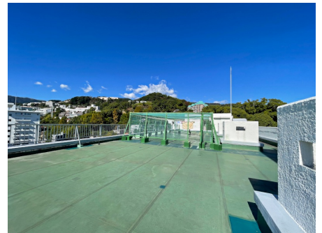
屋上物干しスペース
