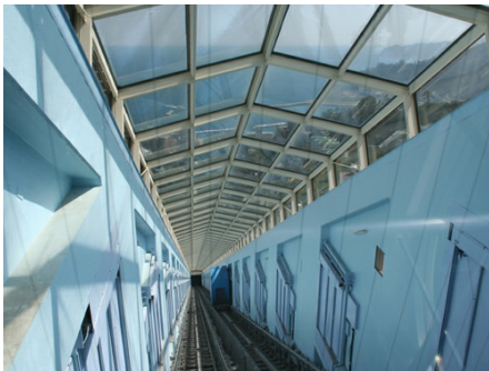
斜行式エレベーター
