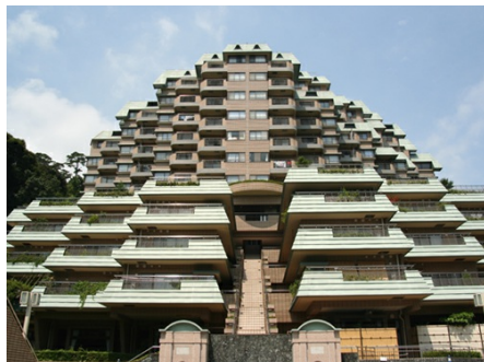
屋外プールからの外観
